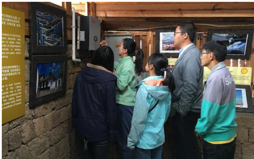
同行们在查看家园太阳能光伏发电电量情况
